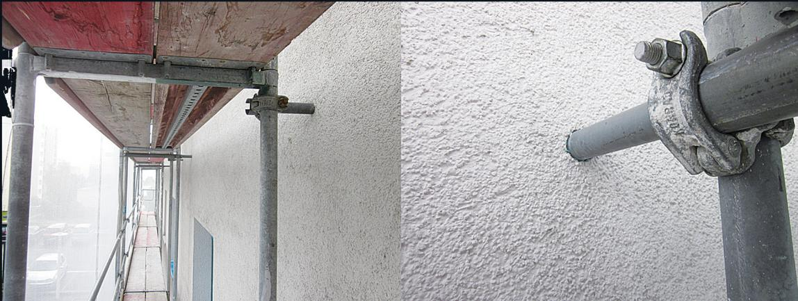
**BILDER: BOHRUNG IN VORHANDENER WÄRMEDÄMMUNG MIT DEM WÄRMEDÄMMBOHRAUFSATZ UND STYROPORVERSCHLUSS.**
