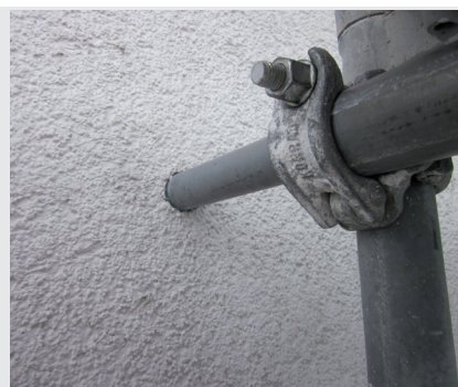
Ankereinbau in vorhandener Wärmedämmung
